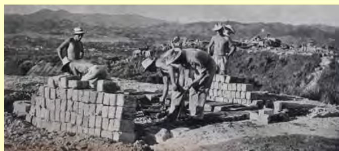
Les soldats qu'on voit à l'œuvre sur cette photo sont des légionnaires. Ils commencent la construction d'un fortin en zone frontière. Ils ne devaient jamais l'achever. L'ordre d'évacuation leur parvenait quatre jours plus tard.
